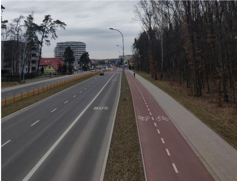
Fotografia 6.2 Pas autobusowy na odcinku prostym
