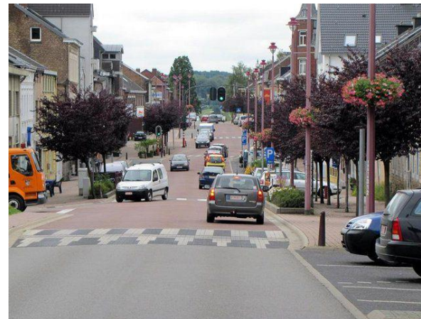
USPOKOJENIE RUCHU DROGOWEGO
